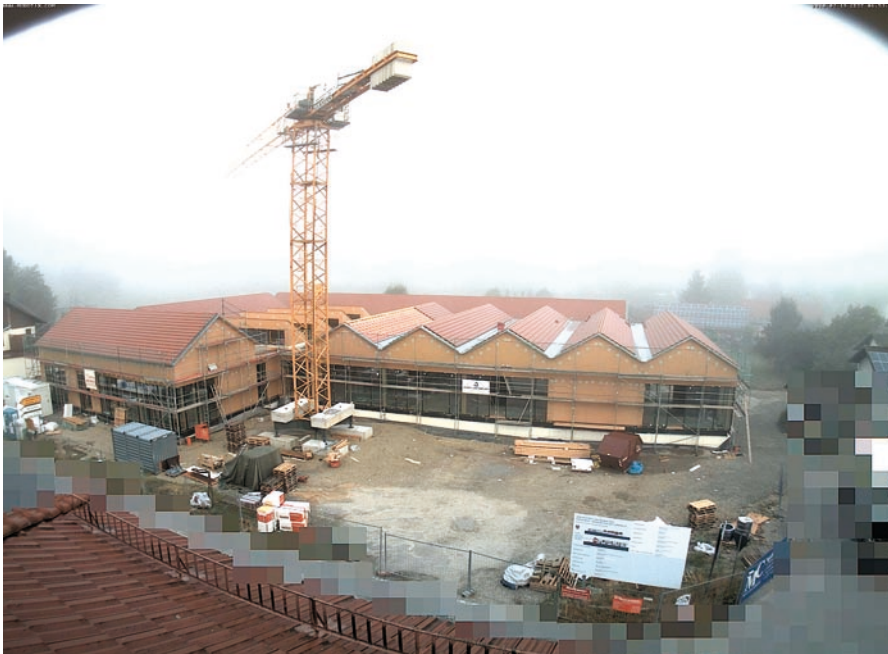
Während der Bauphase wurde jeden Tag ein Foto mit einer Webcam geschossen. Betrachtet man die Fotostrecke im Internet, lässt sich die Geschwindigkeit erahnen, mit der gebaut wurde.
