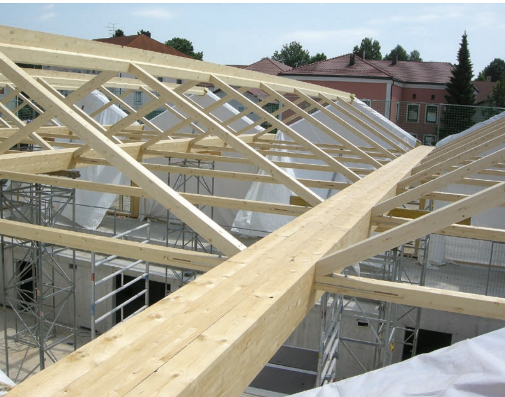
Das Dach der Turnhalle ist eine Mischung aus Stabwerk und Flächentragwerk. Auf die Rohkonstruktion wurden später die Brettsperrholzplatten kraftschlüssig aufmontiert.
