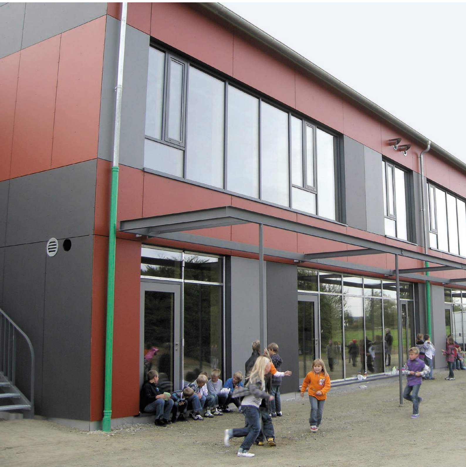
Noch ist der Schulhof nicht ganz fertig, aber die Schüler von Eggldham toben bereits ausgiebig vor und in ihrer neuen Grundschule, einem Holzbau auf Passivhausniveau.
