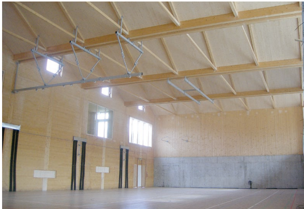
In der Turnhalle ist das Deckentragwerk nach der Fertigstellung gut erkennbar.
