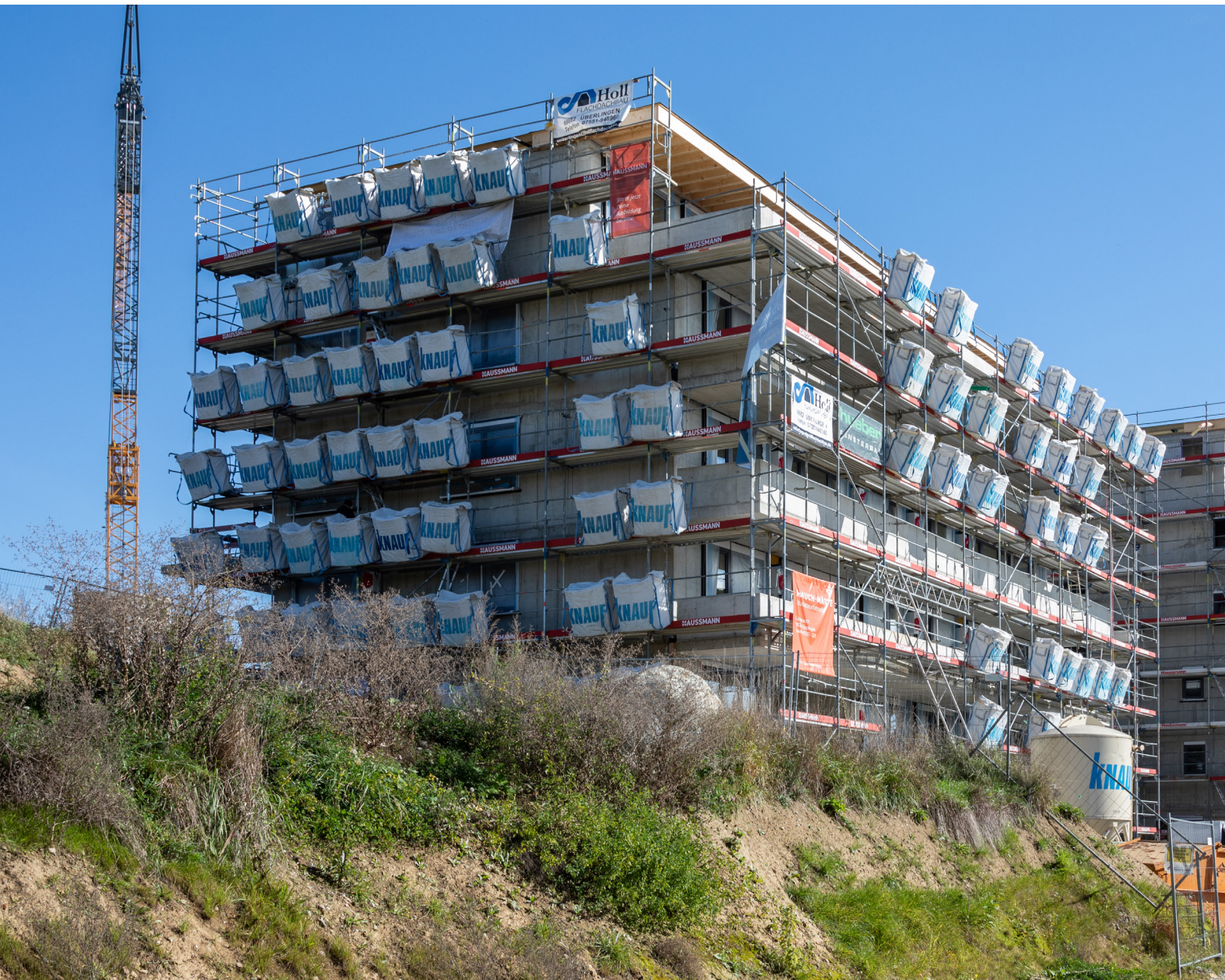
Die Fassadendämmung wurde für einen sicheren Brandschutz mit PU-Dämmstoffen ausgeführt.
