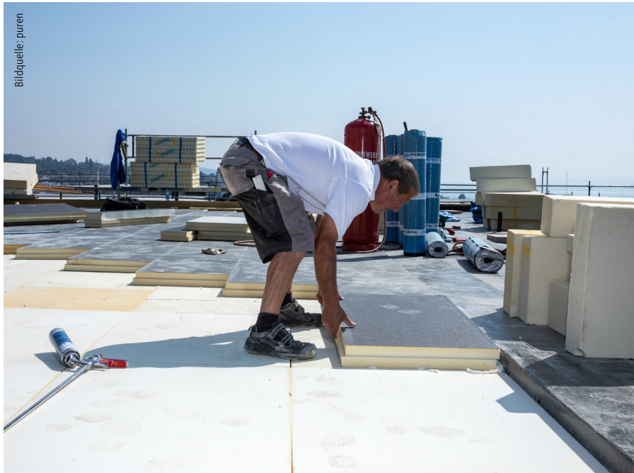
Nach der PU-Gefälledämmung folgt die zweite Dämmlage aus flammhemmenden puren Secure-Dämmplatten.
