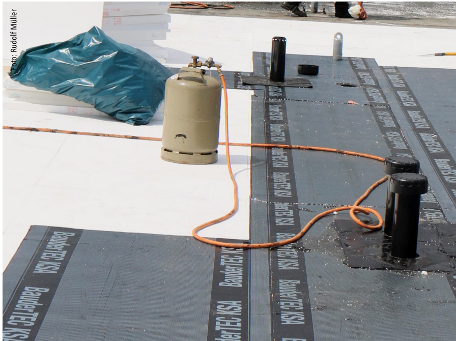
Abb. 4: Flüssiggasbehälter auf der Baustelle
