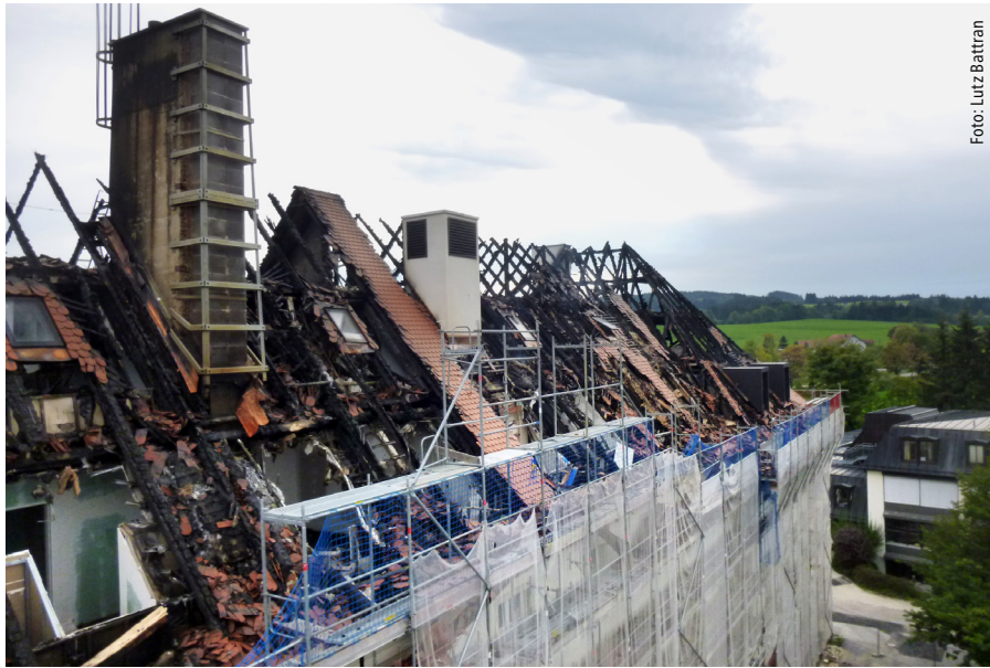
Abb. 6: Brandübertragung über Öffnungen in der Brandwand in einem bereits fertiggestellten Dachraum
