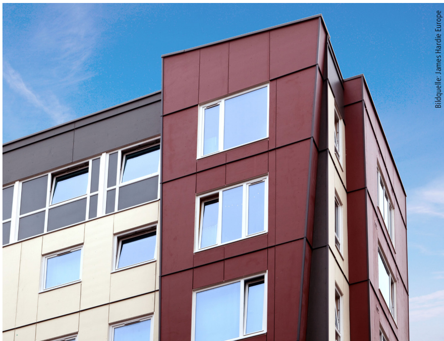
Wirtschaftliche Vorteile bietet die VHF auch bei der zunehmend beliebten Holzrahmenbauweise, da dafür ganze Wandelemente inklusive Fassade vorgefertigt werden können. Zur funktionellen Sicherheit und den wirtschaftlichen Vorteilen kommen die gestalterischen Möglichkeiten des Systems hinzu.
