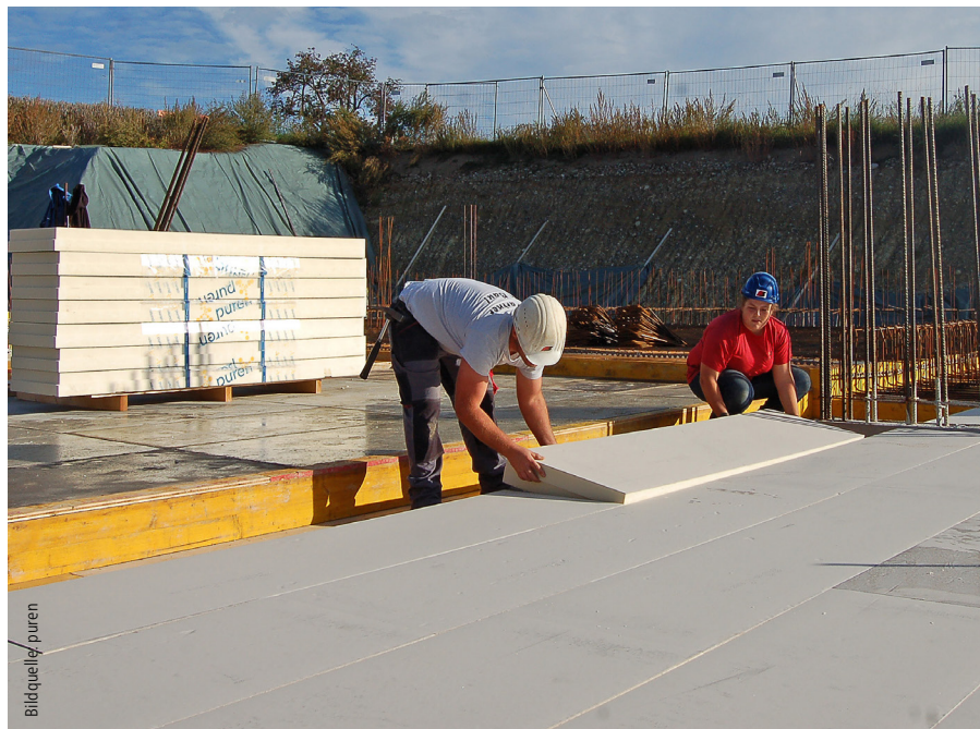
Tiefgaragendämmung als verlorene Schalung vor dem Betonieren auf der Deckenschalung ausgelegt
