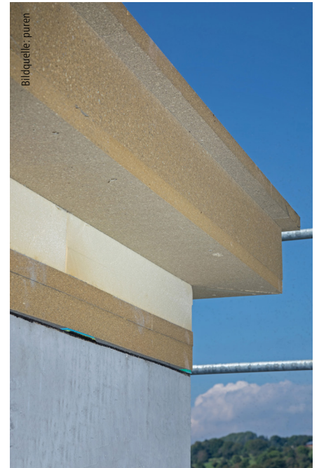
Spezielles Attika-Dämmelement mit oben integrierter Rinne
